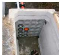
管路を引き込み、柵と接続します。
