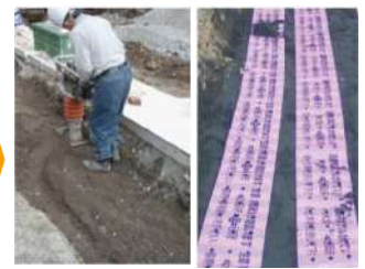
砂で埋戻した後、埋設表示シートと共に埋戻し、工事完了です。
