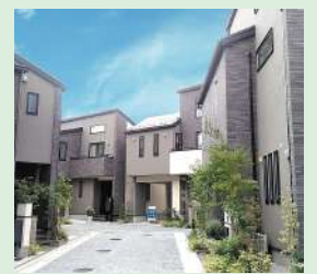
宅地開発無電柱化例 (パイロット事業とは関係ありません)
