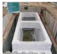
位置を確認してハンドホールを設置します。
