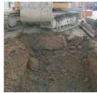
重機やスコップを用いて掘削作業を行います。
