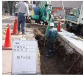
重機を用いて掘削作業を行います。
