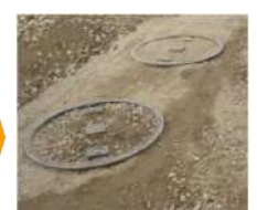
柵蓋を取付け周辺を埋め戻せば工事完了です。
