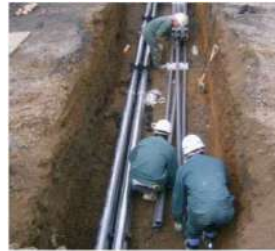
ケーブルを通す管路を敷設します。
