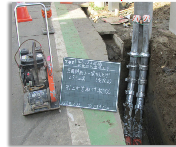
▲電柱への立ち上げ(電力)
