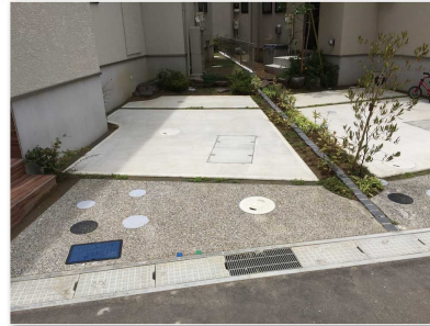
▲宅地内への引込(電力柵・通信柵)
