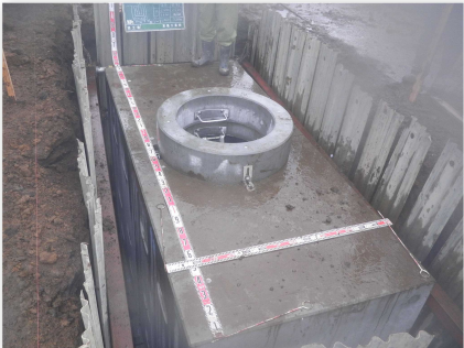
▲ 特殊部設置状況
