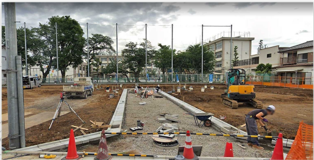
▲ 施工現場状況
