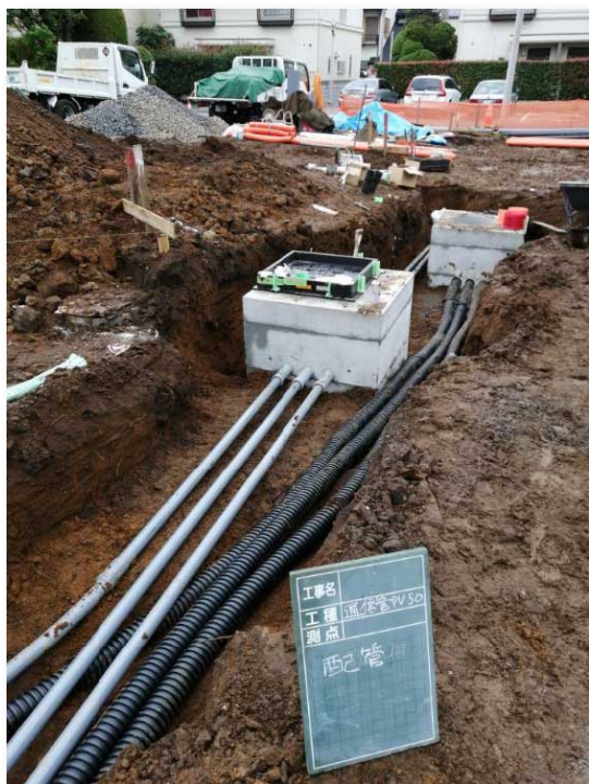
▲ 枡からの分岐管路の埋設状況
