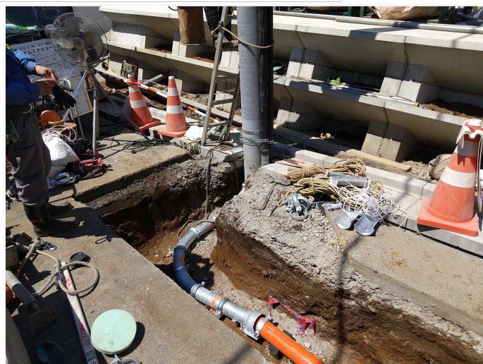
▲ 公道部立ち上げ管路状況
