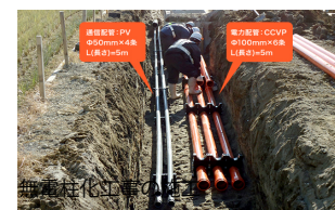
電線共同溝設置工事 無電柱化施工管理 設計監理一式
